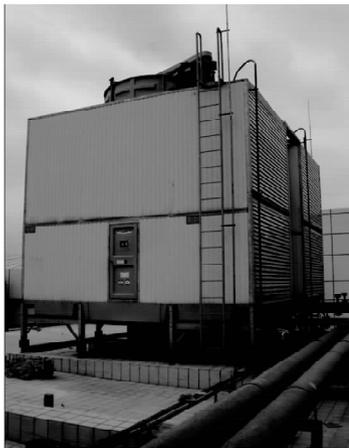
图 1 某负压冷却塔
