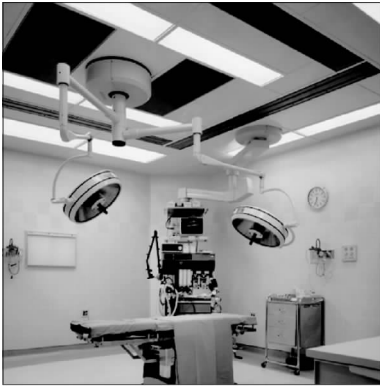
图 9 常规手术室送风装置实景
