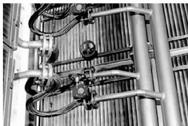
图 11 不锈钢金属软管
