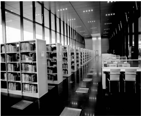
图 1 3 层阅览室地板送风实景
