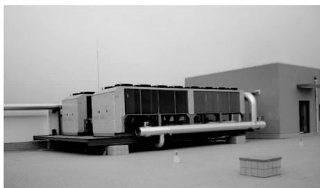
图 1 室外机安装照片
