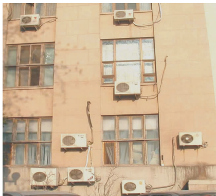
图1 某建筑外立面空调室外机布置情况
