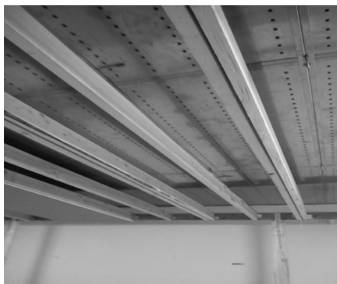
图 1 辐射板搭建支撑架示意与实物图
