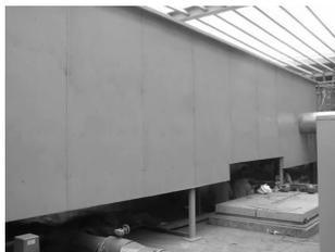
图7 制冷机外隔声装置现场照片
