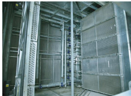
图3 自动开启式表冷器
