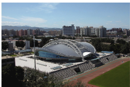
图 1 北京理工大学体育馆外观
