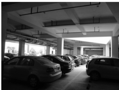
图8 地下车库实景
